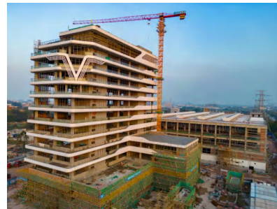
Huigu Construction Site
