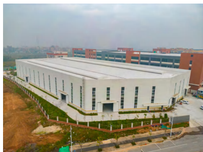
Meilin Construction Site
